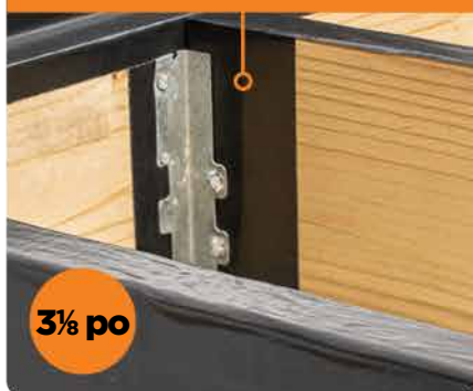
ENTRE L'OSSATURE ET LES SOLIVES MÉTALLIQUES
